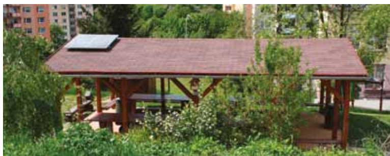
Solární panel na střeše přírodní učebny v ZŠ Rokytnice ve Vsetíně je využíván pro výrobu elektřiny pro ponorné čerpadlo ve sběrné podzemní nádrži na dešťovou vodu.
